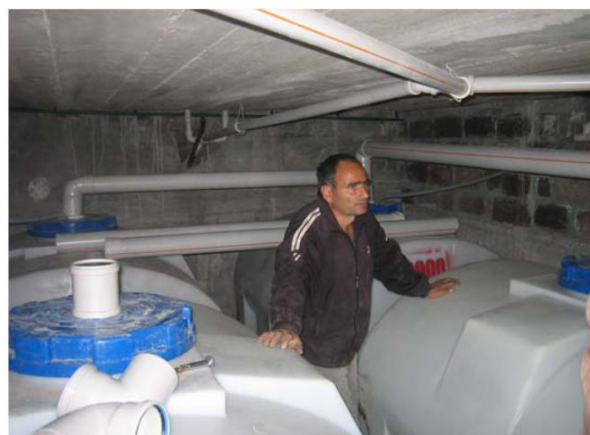
TTHOU i shkollës: bodrum për mbledhjen, deponimin dhe trajtim të urinës për 350 përdorime
