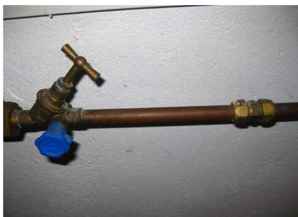
Tubat e bakrit karakterizohen me qëndrueshmëri dhe siguri, por janë relativisht të shtrenjtë.
