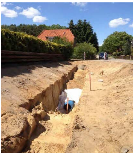
Sistemi i filtrimit Rigol në ndërtim Foto: Arnd Wendland
