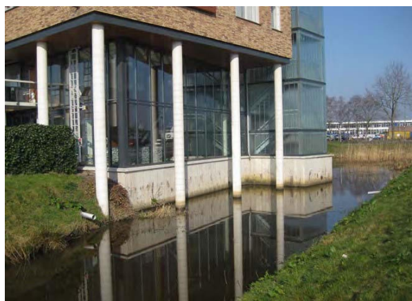
Lëvizja artificiale e ujit/kanal për grumbullimin e reshjeve
